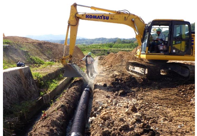
▲暗渠管の埋設
