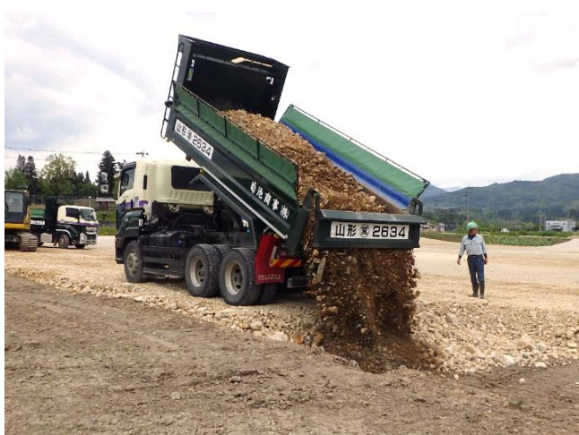
▲盛土材の搬入
