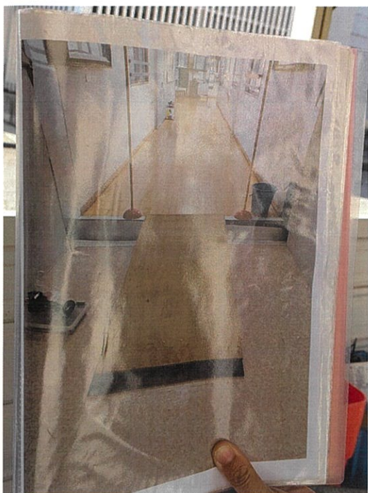
地震の影響で小学校の渡り廊下に段差ができ、スロープを設置したと説明
