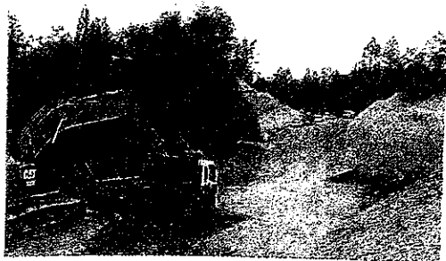
▲着々と進む町道一本松線の新設工事
