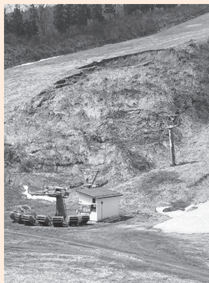
土砂崩れが起きたハートピアゲレンデ
