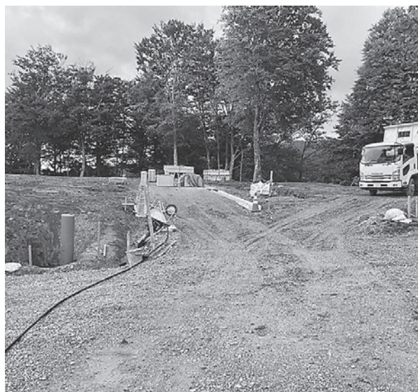
コテージ村再整備事業の外構工事
