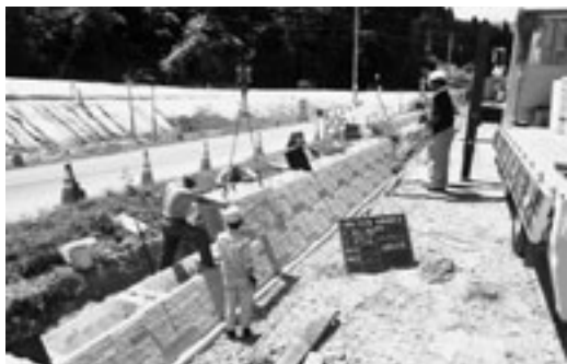
かさ上げ工事が進められている町道雪谷線
