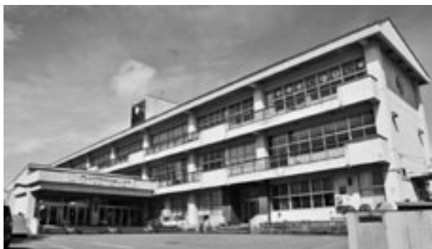
ベランダを改修する宮宿小学校
