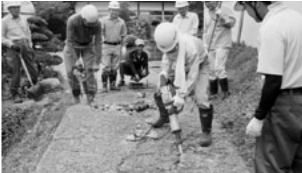
地域住民の手による区道の改修
