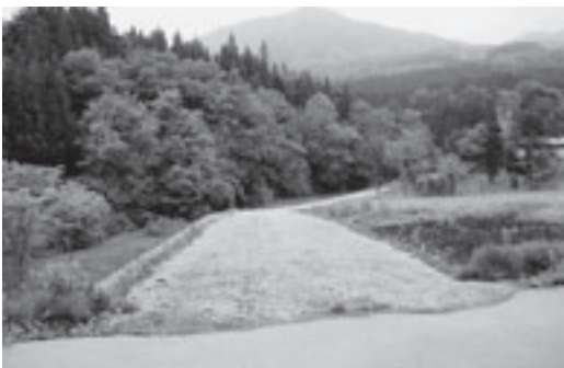
ため池改修に向けた作業道整備の様子
