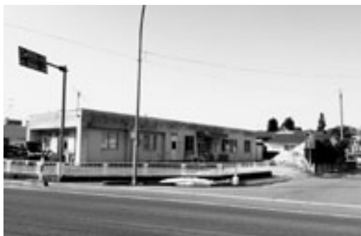
今後改修を行う第 2 公所会館
