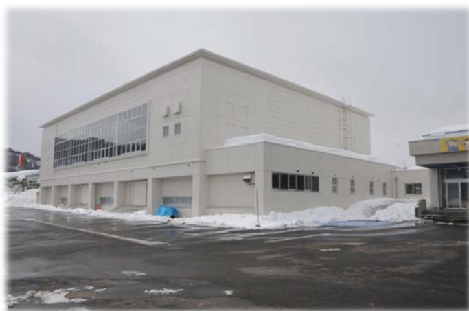
宮宿小学校体育館（平成24年2月完成）
