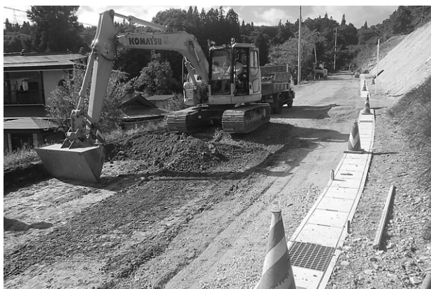
町道三中線の工事
