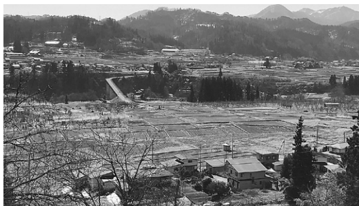
基盤整備事業が実施される能中地内の農地
