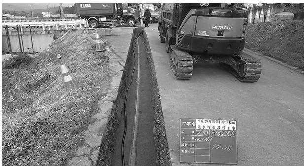
水道管の更新工事
