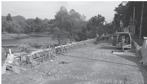
かさ上げ工事が進む町道雪谷線
