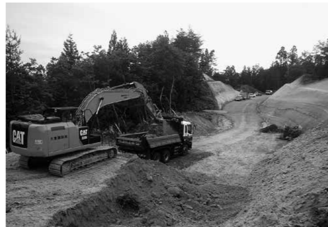
山肌を切り開く町道一本松線の工事
