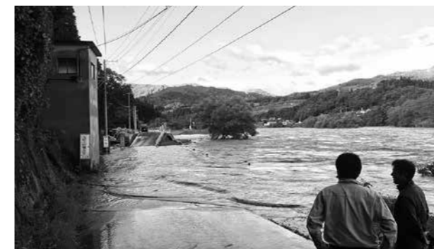
昨年10月、台風による増水で冠水した道路
