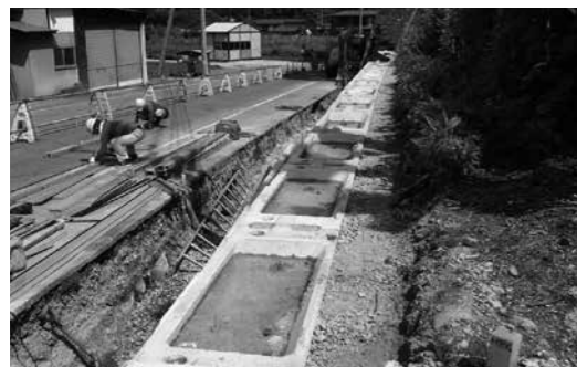
町道西町西原線の工事
