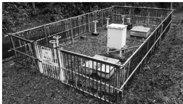
現在の八ツ沼配水池
