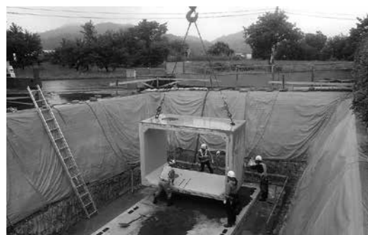
耐震性貯水槽の設置工事
