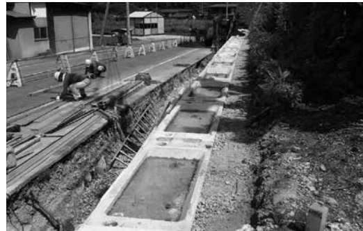
町道西町西原線の工事
