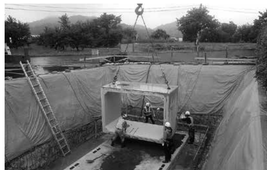
耐震性貯水槽の設置工事
