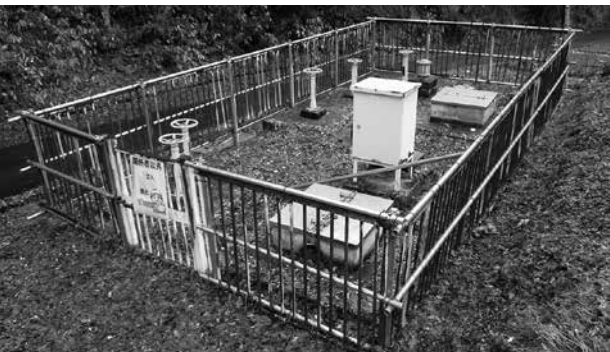
現在の八ツ沼配水池
