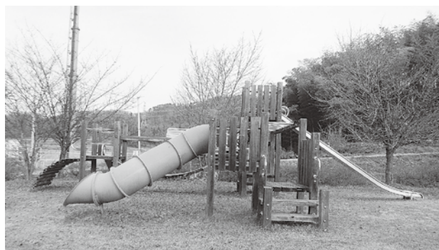
老朽化により更新される遊具
