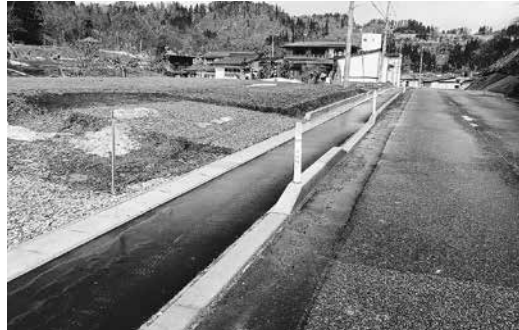
歩道の整備が進む町道西町・西原線
