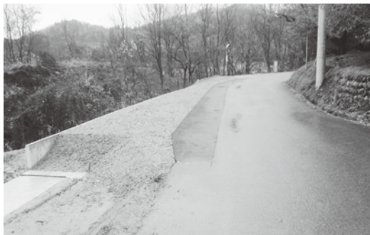
改良が進む町道赤釜線
