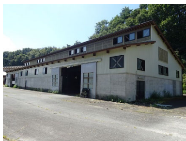
堆肥センター穀保管庫
