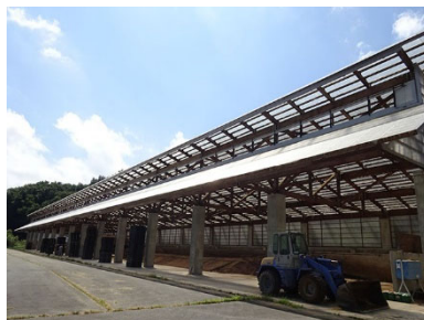
堆肥センター発酵棟
