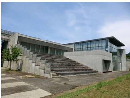
エコミュージアム コアセンター創遊館
