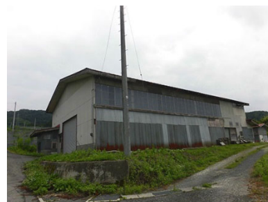
除雪機械格納庫
