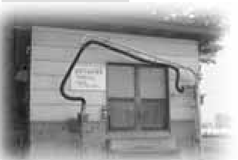
廃止されることが決まった中間貯留槽(国道287号線四ノ沢地内岩坂橋付近)
