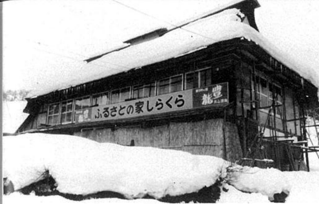
内部改造し宿泊が可能になったふるさとの家
