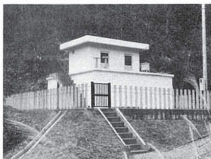
滅菌室などが整っている配水池
