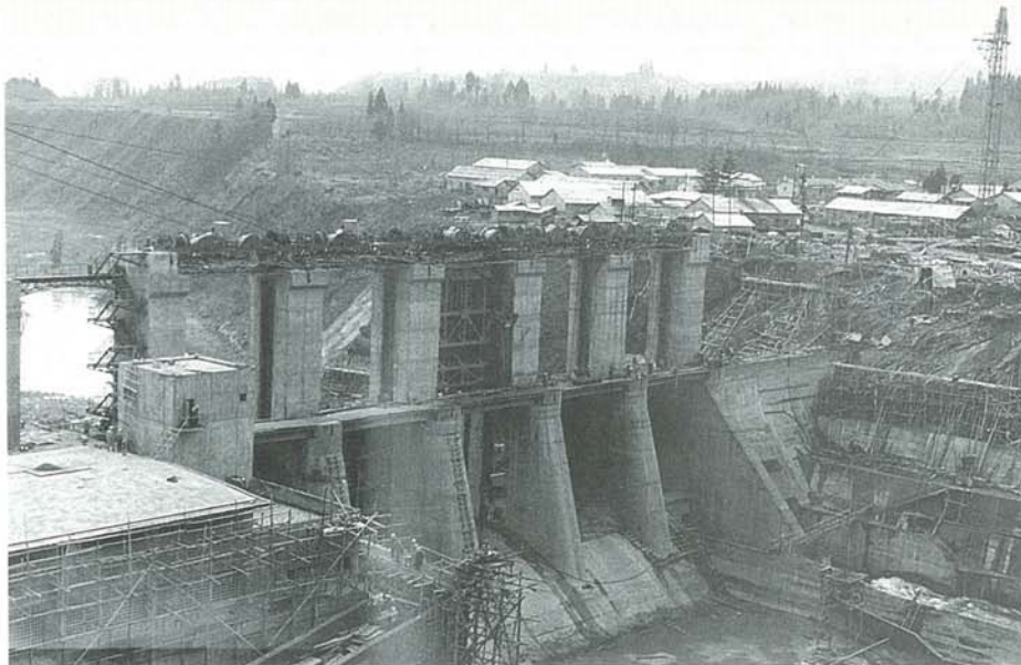
上郷ダム発電所建設（昭和37年完成）
