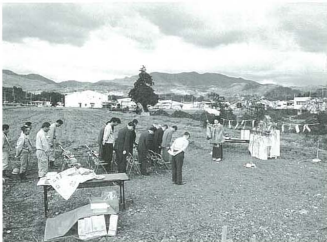
宮宿中郷住宅団地の造成工事始まる（平成5年）
