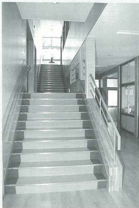
階段途中の踊り場が体育館の入口になっている
