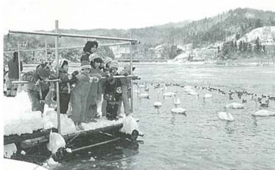
転落防止のため手すりが新たに設置された
