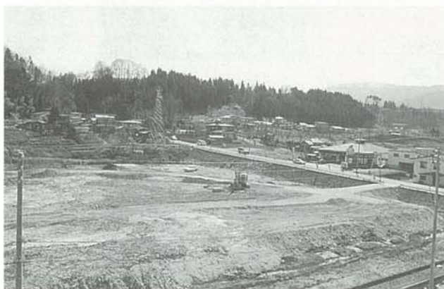
役場南側に建設予定の生涯学習センター
