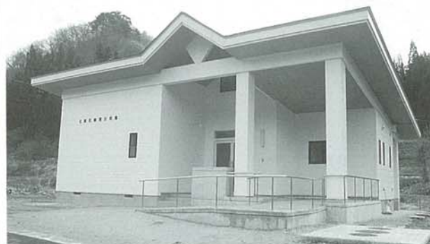
新築された曲淵公民館
