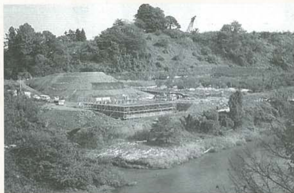
橋台工事が進む新しい明鏡橋
