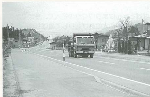
12月26日に一部開通した和合バイパス
