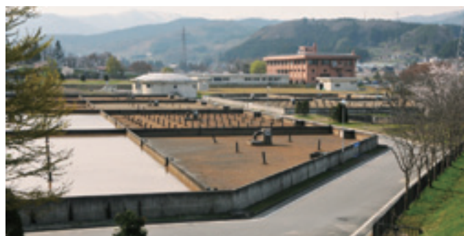
村広水の水は西川町沼山で寒河江川より取水され（上）、同町吉川にある施設（下）で浄水されている。右は大谷にある村広水の配水池（タンク）
