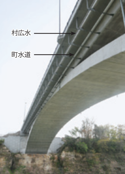
新明鏡橋の下を走る町及び村広水の水道管。こうした配管工事を支えるのも使用料
