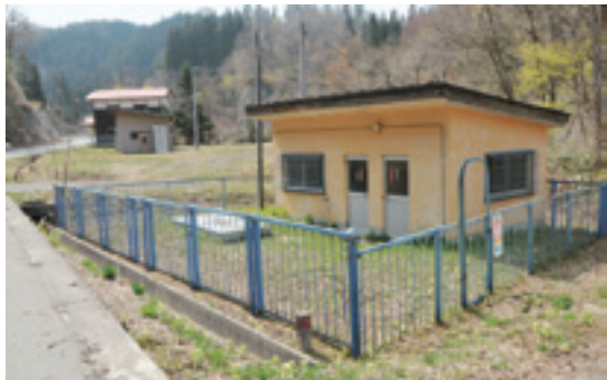
一ツ沢水源の滅菌室（立木地内）
