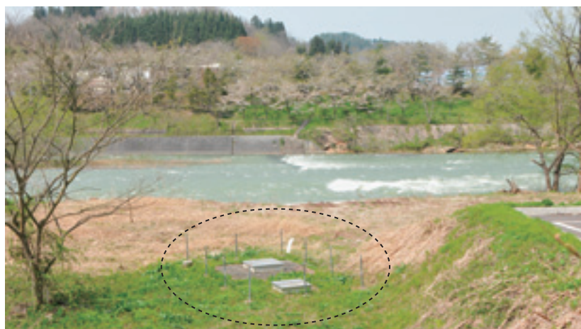
(上) 最上川のそばにある雪谷水源。河川の伏流水を利用している
