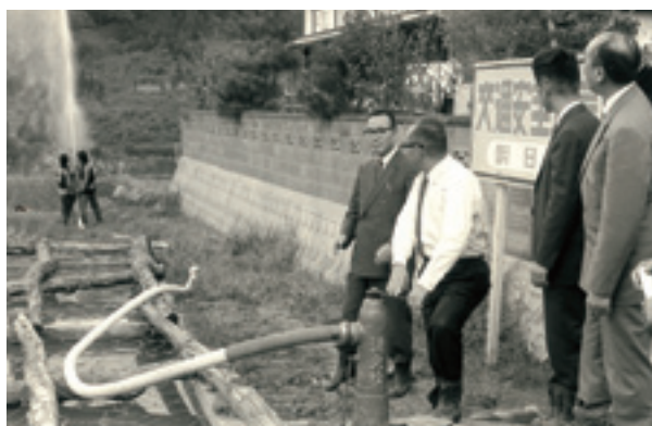
杉山地区の簡易水道完成にあたり、記念行事で消火栓を操作し通水を確認する志藤武志元町長（昭和 46 年 11 月）
