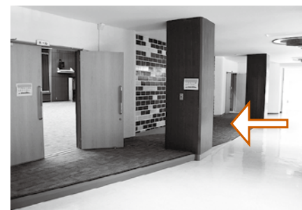
▲開発センターホール入口。中央部の段差が解消され、車イスでも出入りしやすくなった
