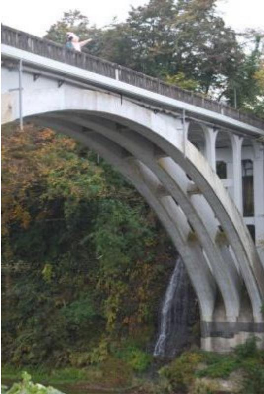
古きよき味を残す明鏡橋の欄干ですが、橋脚部分是对照的に丈夫な近代的なつくりになっています(橋脚は最近補修されたばかり)。
