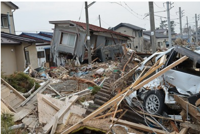
▲ 中央の家屋はおそらく2階部分だけ流されたもの(1階部分がない)
