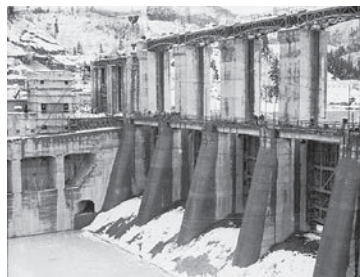
③完成間もない上郷ダム発電所
