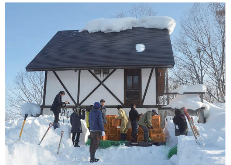
去年12月の作業の様子。屋根からの雪がたまりやすい場所に雪室を作った
