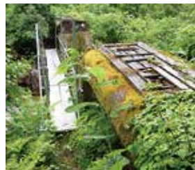
▲登山道の整備(左)。壊れた橋の代わりに単管パイプで架橋(右)。山岳会の活動が朝日連峰の登山を支えている
