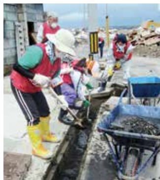
被災地での側溝の泥上げ作業。後ろには、がれきが堆積しています
