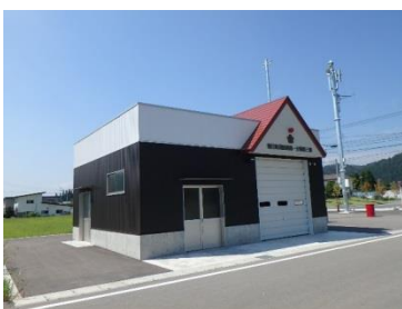
防災拠点施設整備(備蓄倉庫)
